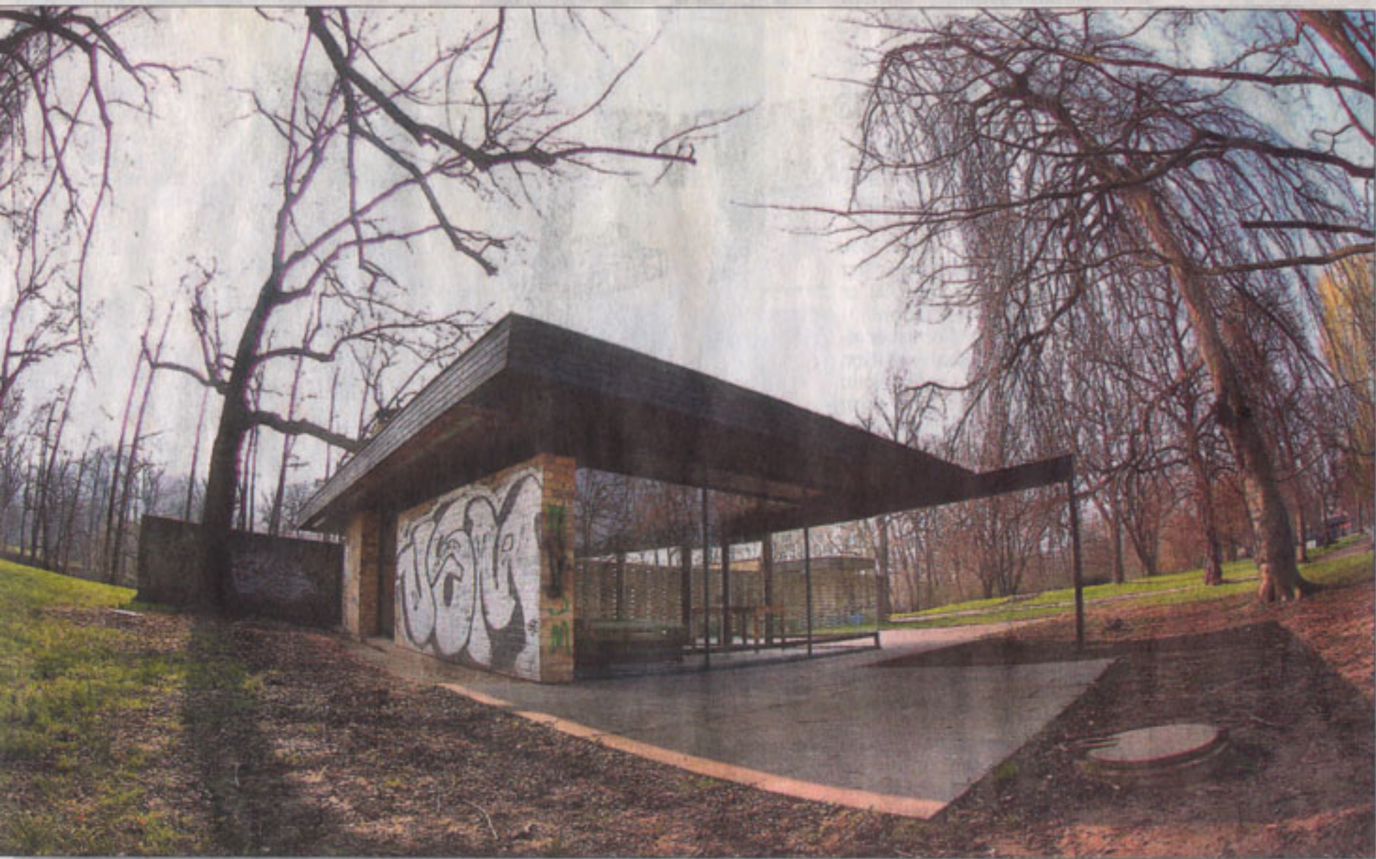
LANGE VERKANNT: Pavillon in der Architektur der Moderne sieht besseren Zeiten entgegen, soll saniert und genutzt werden.
